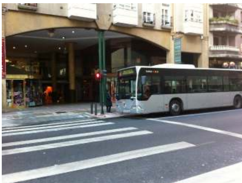
Foto 36. Paso de cebra con ancho sin pintar para pasar en bici.
