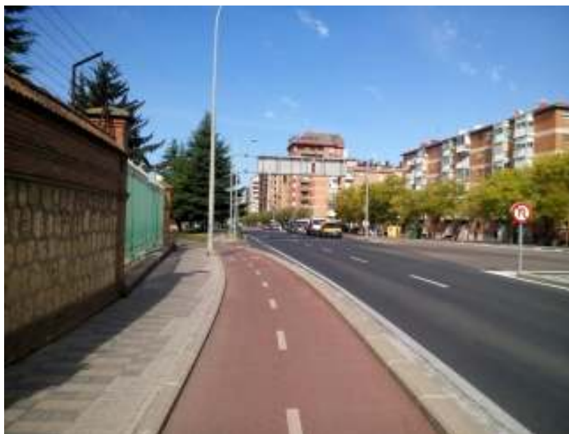
Foto 25. Tramo del carril bici donde se propone abrir un refugio para el cruce.
