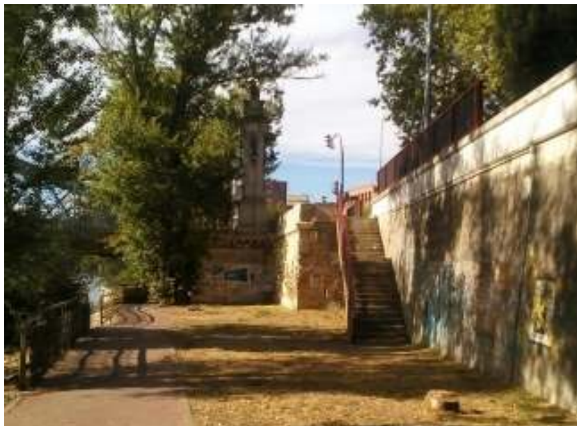
Foto 7. Escalera entre Avenida de Castilla y el parque del río.
