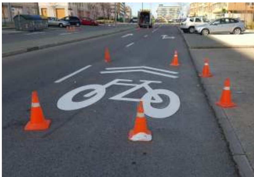
Foto 31. Pintando un ciclocarril en Alcalá de Henares (Madrid).
