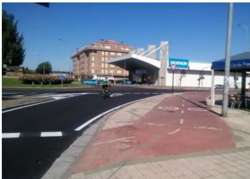
Foto 4. Calle de Nivel de Calidad 2 (Control).
