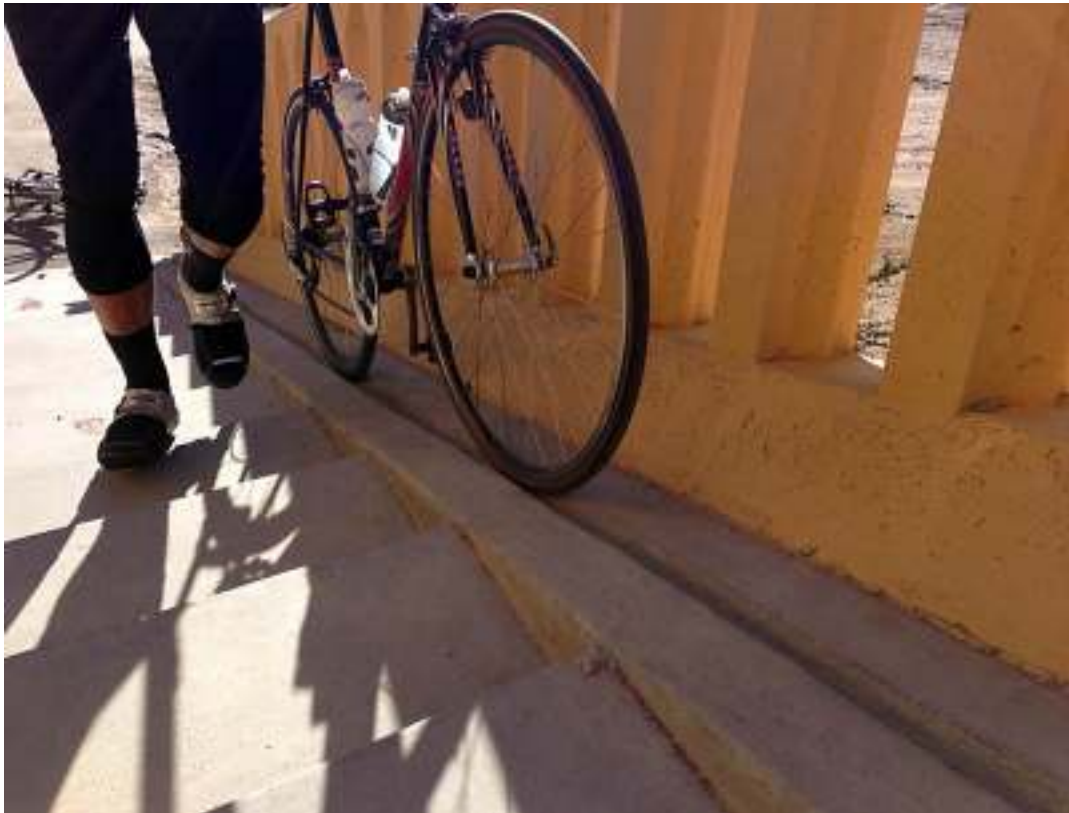
Foto 16. Ejemplo de rampa o "canal" para bicis en cemento.
