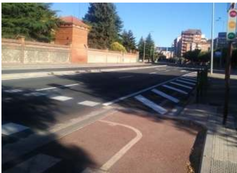
Foto 26. Extremo del carril bici a adaptar para la incorporación a la calzada.
