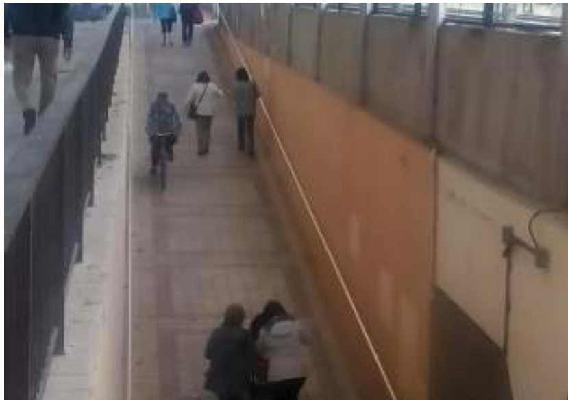
Foto 6. Paso subterráneo bajo la vía.
