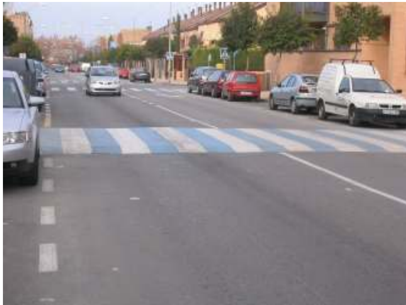
Foto 34. Paso peatonal elevado en Pinto (Madrid).
