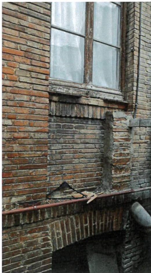
Imagen 16-17. Fotografías de la modificación de huecos de fachada
