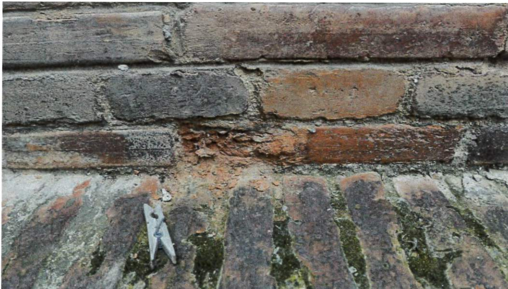
Imagen 19. Fotografías de la degradación del ladrillo
