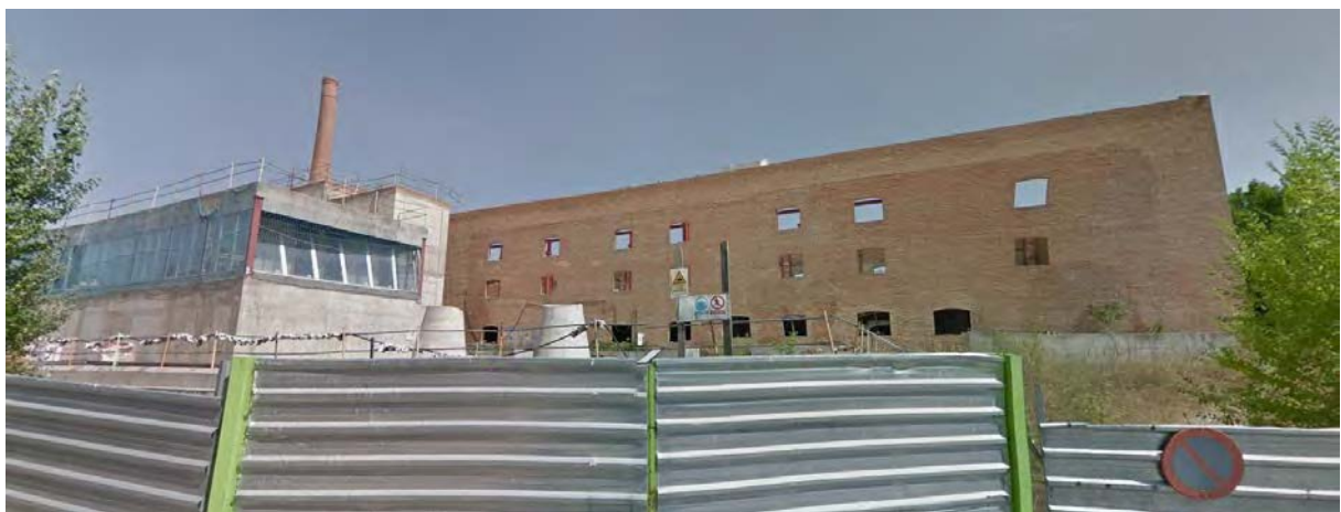
Vista desde la Carretera de Santander. Sur de la parcela.
