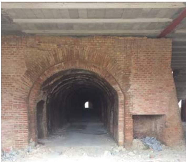
Detalle de los hornos de cocción originales con el nuevo forjado construido sobre ellos.
