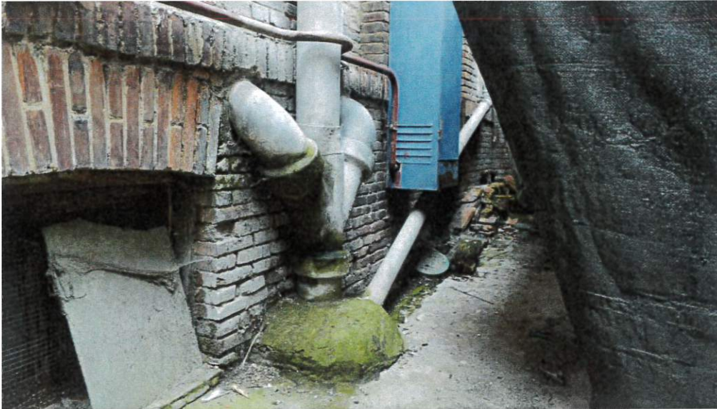
Imagen 14. Fotografía de las perforaciones para la red de saneamiento
