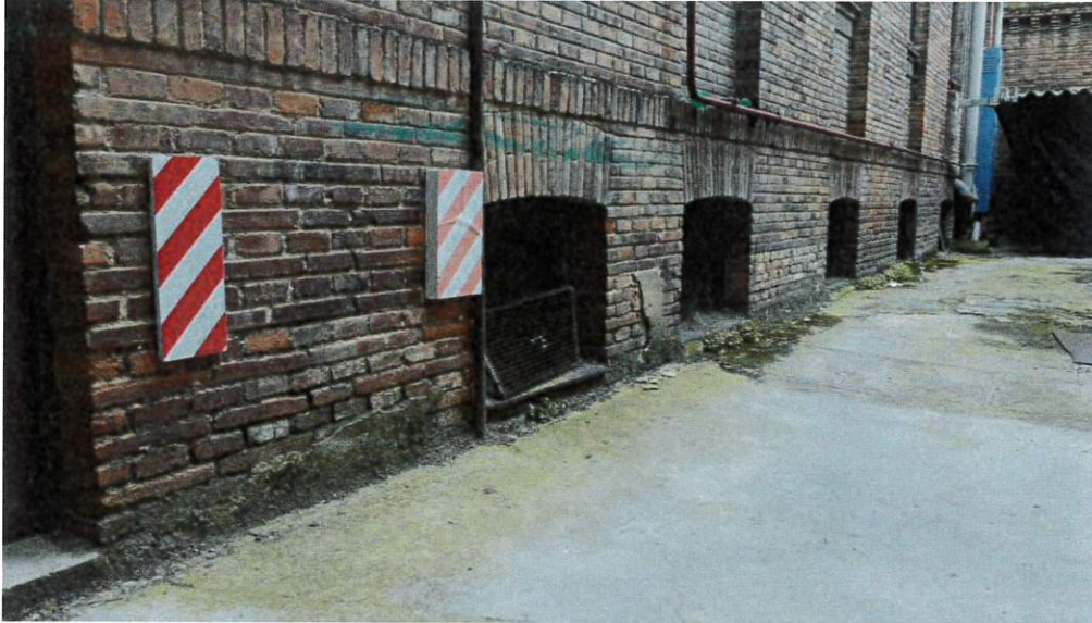
Imagen 18. Fotografías de las humedades existentes en el arranque de la fachada
