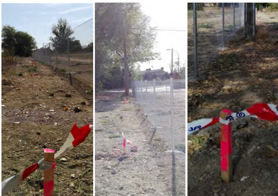
Imagen 3.-Puntos replanteados con estacas.
