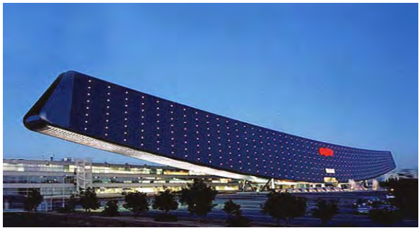
Edificio Puente: Sanyo Solar (exposición universal Aichi) forrado de 5000 paneles solares.
