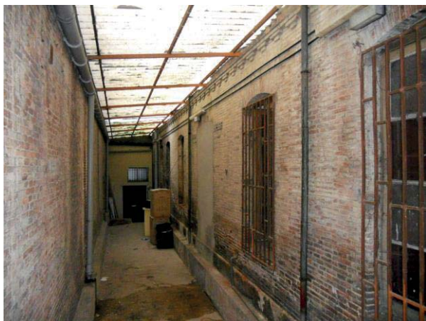
CUBIERTA DE POLICARBONATO EN PATIO
