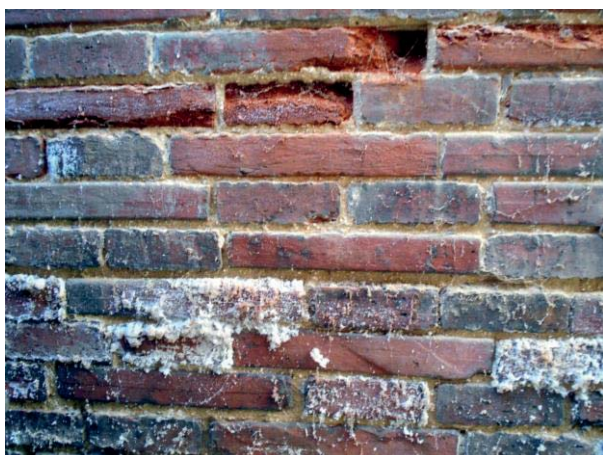
LADRILLOS DEGRADADOS EN LA PARTE INFERIOR DE LOS MUROS DE FACHADA AL PATIO INTERIOR
