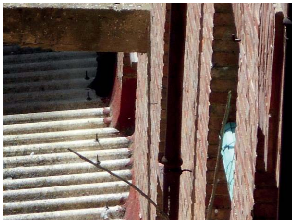
BABERO IMPERMEABILIZANTE EN FACHADA
