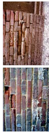
9 DEGRADACIÓN DEL LADRILLO POR HUMEDAD Y MICROORGANISMOS
