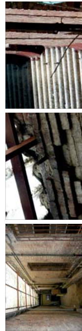
8 CUBIERTA DE POLICARBONATO EN PATIO CON EMPOTRAMIENTO Y BABERO EN FACHADA
