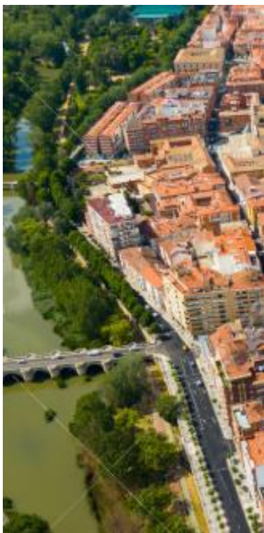
Ilustración 27 El Parque Fluvial del Carrión, elemento de referencia de la red de espacios libres
