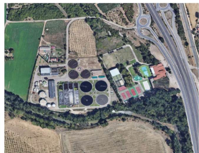
Depuradora de Palencia (EDAR)
