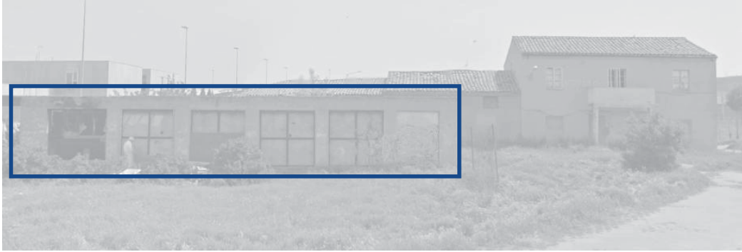
Imagen 4. Visual de la edificación adjetiva en primer plano desde la calle Tello Téllez.
