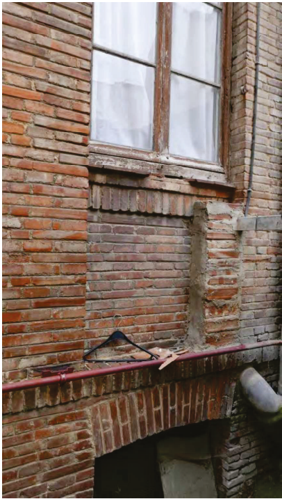
Imagen 16-17. Fotografías de la modificación de huecos de fachada
