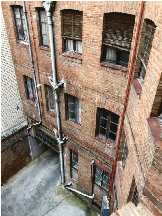
Imagen 13. Fotografía de la alteración de la fachada por colocación de instalaciones
