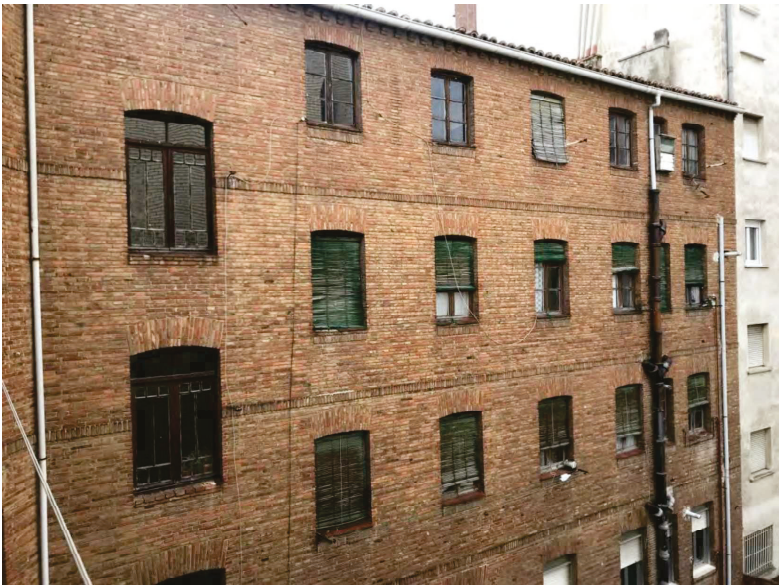
Imagen 10. Fotografía de la fachada al patio interior
