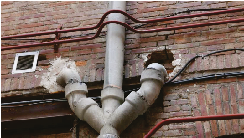
Imagen 15. Fotografía de la alteración de la fachada por colocación de instalaciones
