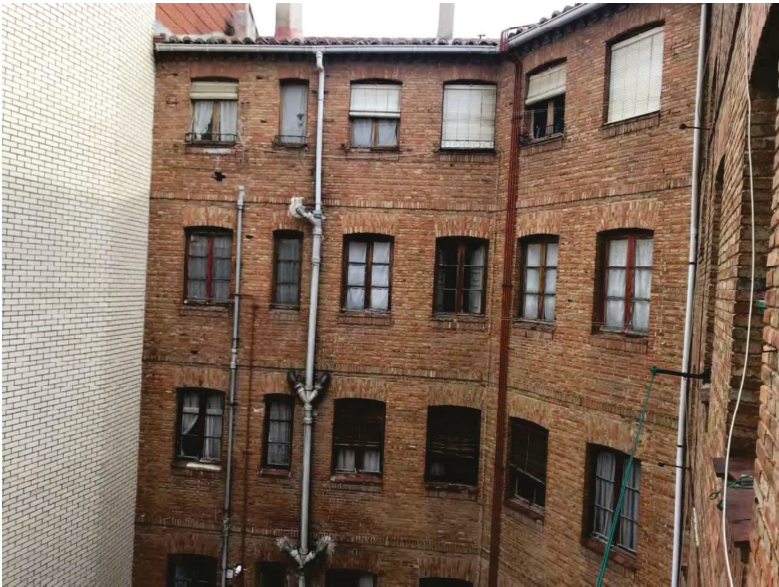
Imagen 11. Fotografía de la fachada al patio interior
