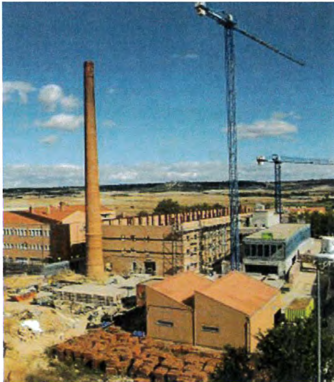
Vista de detalle desde la Calle Clara Campoamor, oeste de la parcela.
