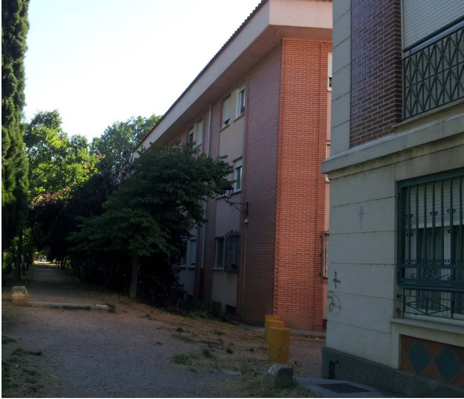
21. Edificaciones limítrofes con el camino de sirga.
