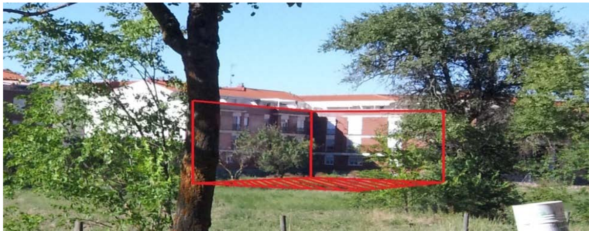
27. Imagen y composición, zona de la Parcela 33 Polígono 15 Santa Ana y frentes del edificio existente.
