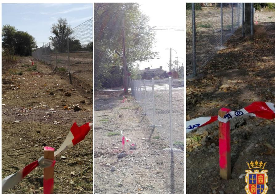
Imagen 3.-Puntos replanteados con estacas.
