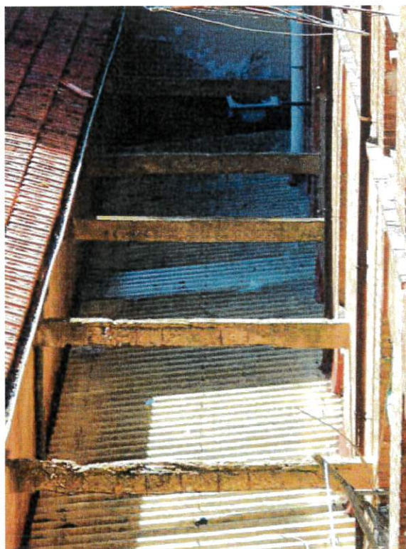
VIGAS DE HORMIGÓN ENTRE FACHADAS
