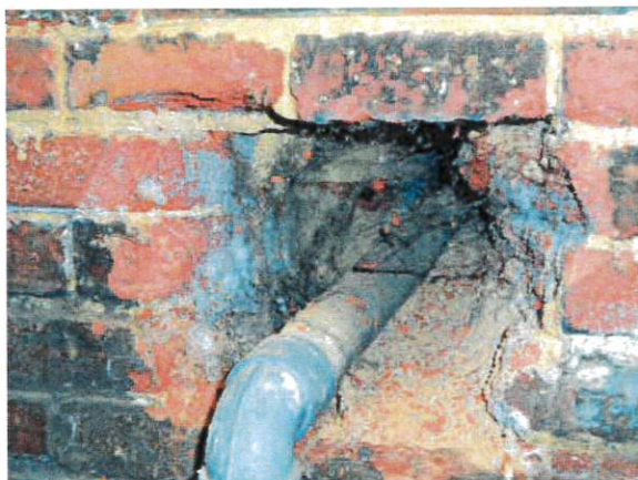
HUECOS EN FACHADA PARA INSTALACIONES
