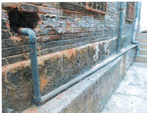
RECIMENTACIÓN DE HORMIGÓN
