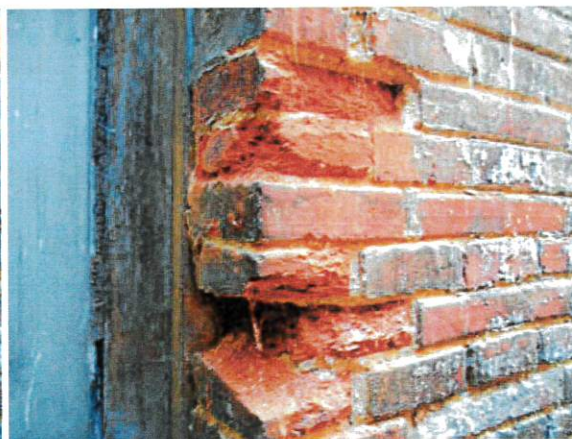
LADRILLOS DEGRADADOS EN LA PARTE INFERIOR DE LOS MUROS DE FACHADA AL PATIO INTERIOR
