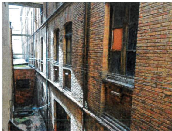
CUARTOS DE CALDERAS AÑADIDOS EN PATIO
