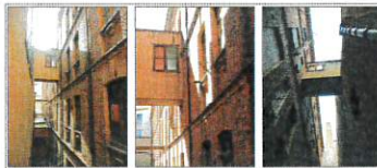
3 PUENTE DE PASO AL EDIFICIO DEL INTERIOR DE LA MANICANA
