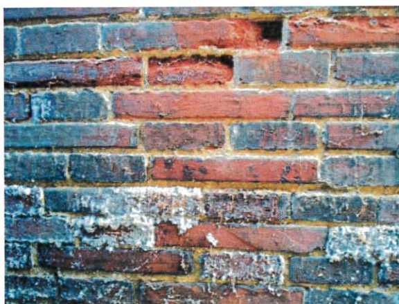
LADRILLOS DEGRADADOS EN LA PARTE INFERIOR DE LOS MUROS DE FACHADA AL PATIO INTERIOR
