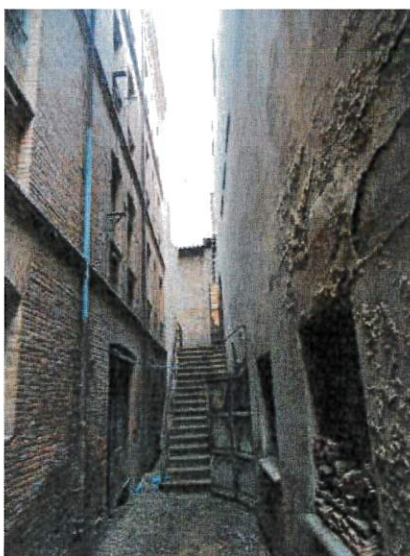
FACHADA INTERIOR DESDE EL PATIO DE LA PARCELA
