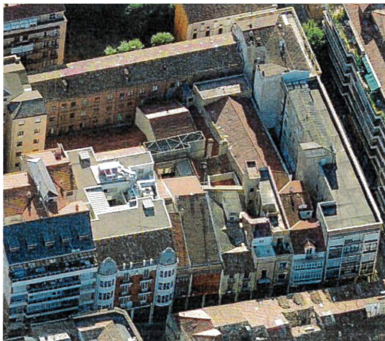
VISTA AÉREA DE LA FACHADA
