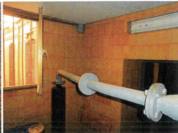
FACHADA ALICATADA EN CUARTO DE CALDERA
