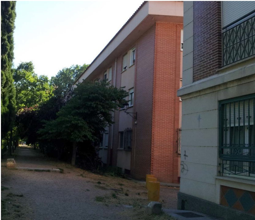
19. Edificaciones limítrofes con el camino de sirga.
