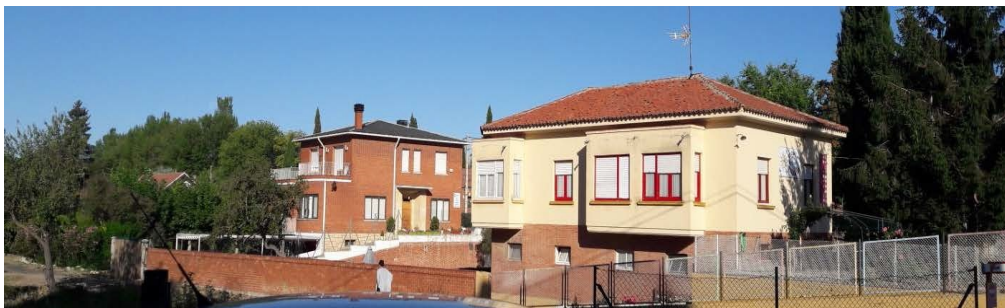
16. Zona centro y Este del PERI 5. Escuela infantil, próxima a la Dársena del Canal.
